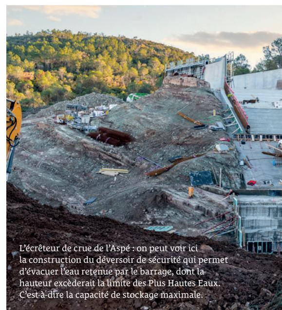
L'écrêteur de crue de l'Aspé : on peut voir ici la construction du déversoir de sécurité qui permet d'évacuer l'eau retenue par le barrage, dont la hauteur excéderait la limite des Plus Hautes Eaux. C'est-à-dire la capacité de stockage maximale.
